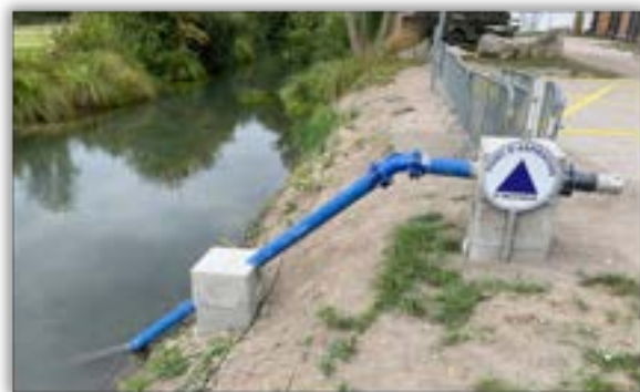
Exemple de réalisation à Ailly sur Noye
