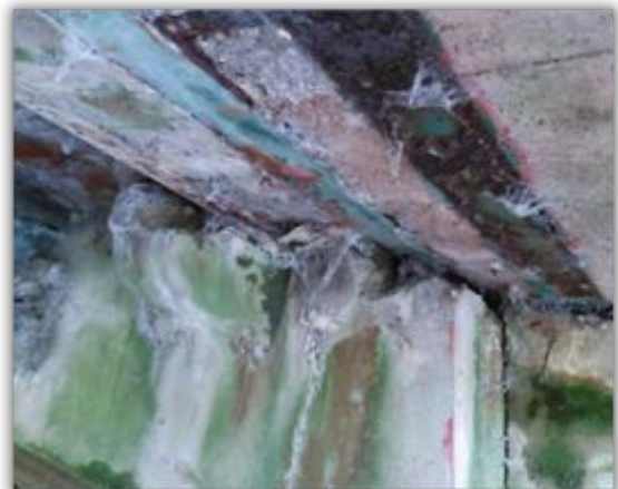
Corrosion avancée des semelles inférieures des poutrelles, début de feuilletage
